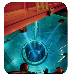
Fig. 10.14 Reactorkern in een ruimte met onderdruk
